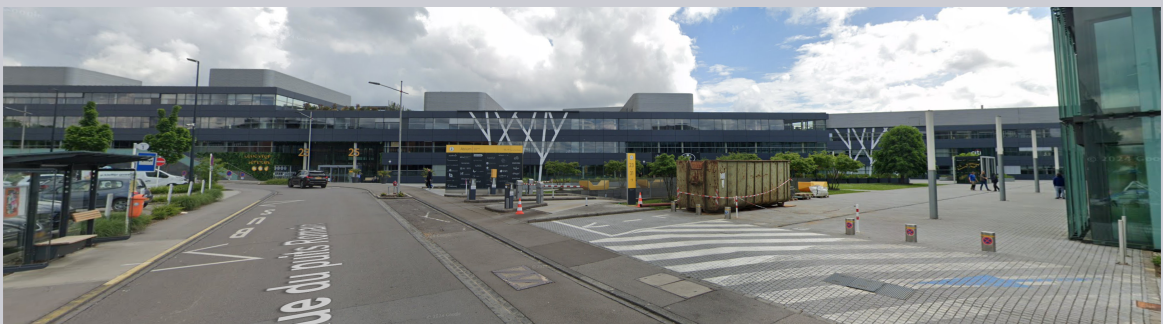
Atrium Business Park - Ansicht von Westen
