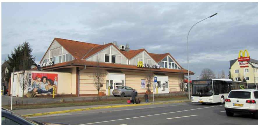
Abb. 5: Bestand an der route d'Arlon im Bereich 2, Quelle: a+a, eigene Aufnahme
