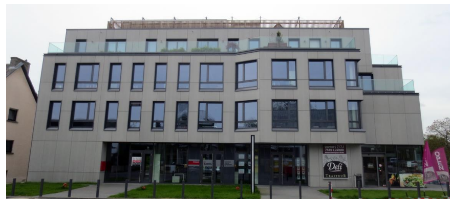
Abb. 11: Referenzbeispiel städtische Mischbebauung an der route d'Arlon, die Fortgeschrieben werden könnte, Quelle: a+a, eigene Aufnahmen Karsten Harz
