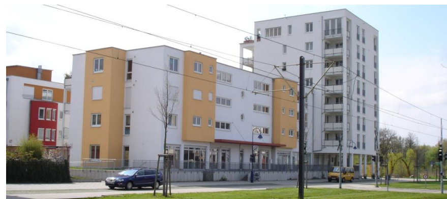
Abb. 10: Referenzbeispiel für eine viergeschossige, geöffnete Blockrandbebauung mit einer städtebaulichen Dominante in Freiburg (Siedlung Rieselfeld), die in ähnlicher Form auch in Bereich 1 implementiert werden könnte, Quelle: a+a, eigene Aufnahme Karsten Harz
