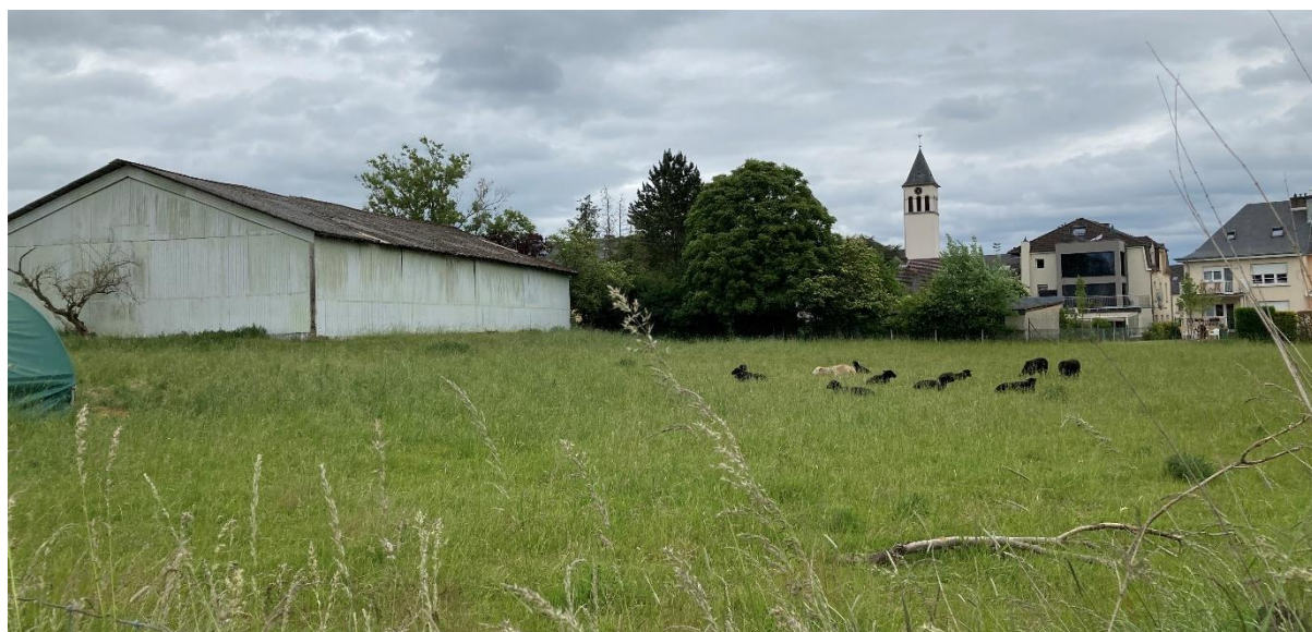
Photo 3 : vue sur la partie nord-est du site et le hangar qui sera démolis (Source : BEST)
