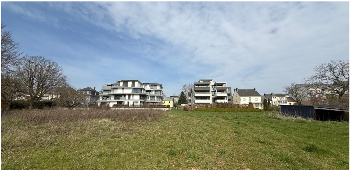
Photo 8 : vue sur l'arrière des constructions sises 103a, 105 et 107, Rue des Romains (Source : BEST)
