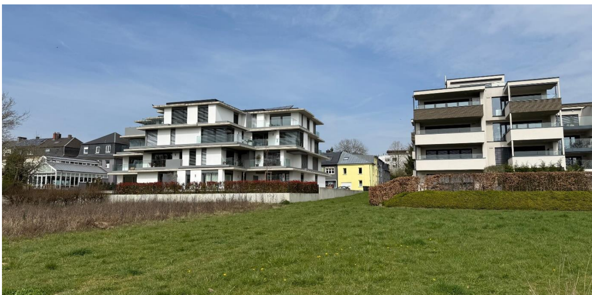
Photo 9 : vue sur l'arrière des constructions sises 103a, 105 et 107, Rue des Romains (Source : BEST)
