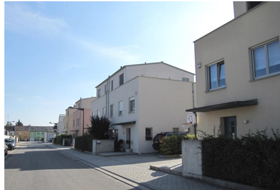
Abb. 5: Referenzbeispiel Wohnstraße mit Doppelhäusern, Cité „Am Wenkel“, Bertrange, Quelle: a+a, eigene Aufnahme Karsten Harz
