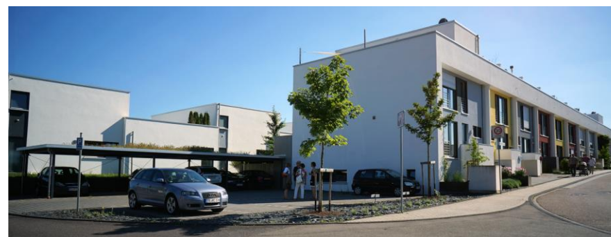
Abb. 11: Referenzbeispiel privates Sammelparken im Carport bei Doppel- und Reihenhäusern, Quelle: a+a, eigene Aufnahme Karsten Harz
