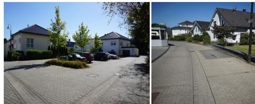
Abb. 8: Referenzbeispiel Sammelparken und Parken im Straßenraum bei Mischprinzip, Quelle: a+a, eigene Aufnahmen Karsten Harz
