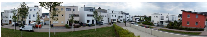
Abb. 3: Referenzbeispiel verdichtetes Einfamilienhaus-Wohngebiet BU 13 Am Freschfeld, Trier, Quelle: Quelle: a+a, eigene Aufnahmen Karsten Harz
