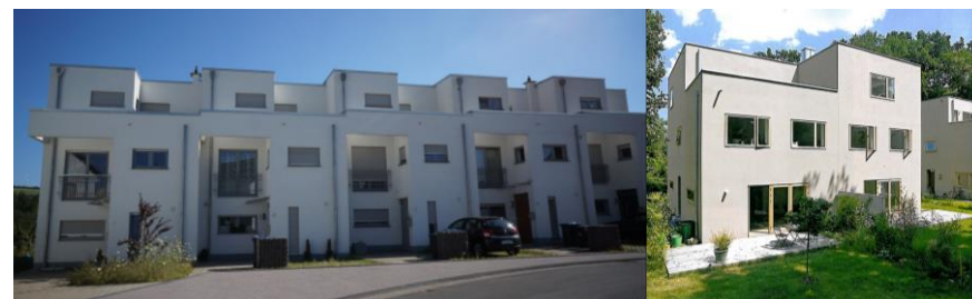
Abb. 7: verdichtete Einfamilienhaus-Bauformen Quelle links: a+a, eigene Aufnahme, Quelle rechts: Referenzbeispiel Doppelhäuser, Quelle Doppelhäuser in Berlin-Weißensee, DETAIL 05/2007, S.493
