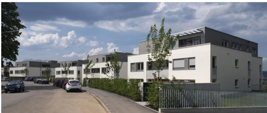
Abb. 5: Städtische Mehrfamilienhaus-Bebauung in Esslingen-Zollberg, die in ähnlicher Form auch an der rue de la Chapelle implementiert werden könnte, , Quelle: http://www.competitionline.com/de/projekte/50231 , download: 25.06.2013
