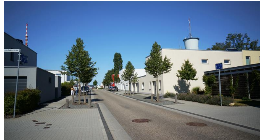
Abb. 8: Referenzbeispiel Anlieger-/Erschließungsstrasse im Trennprinzip/Tempo-30-Zone, Petrisberg Trier, Quelle: a+a, eigene Aufnahmen Karsten Harz
