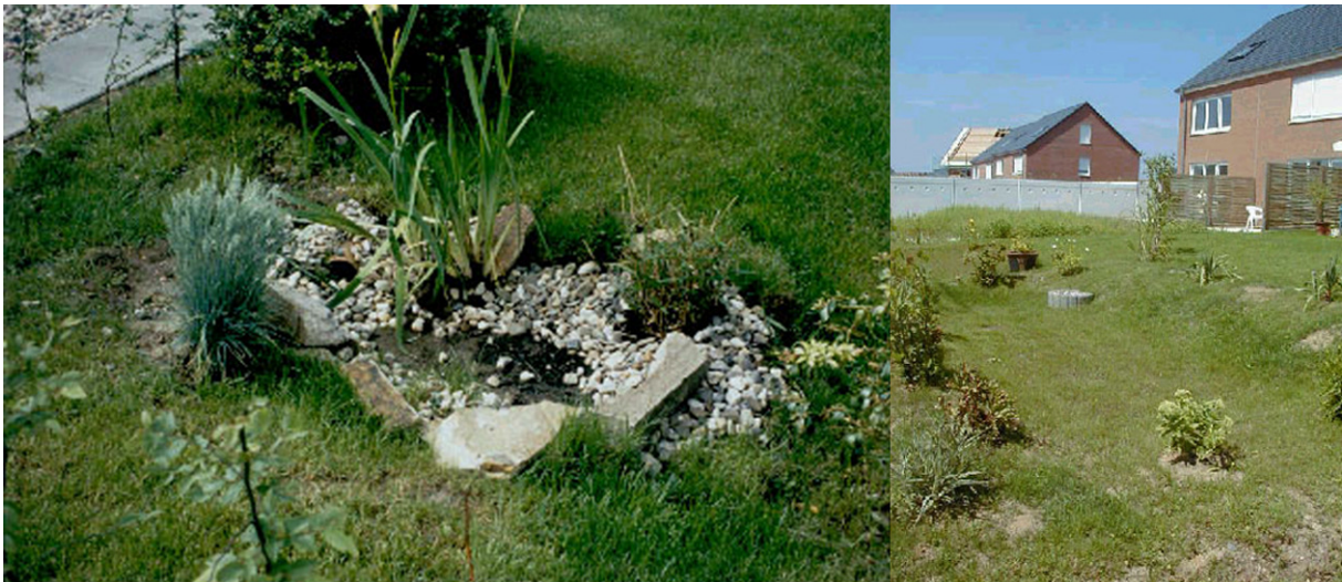
Abb. III.38 Beispiele dezentraler Regenwasserversickerung - Versickerungsmulden
