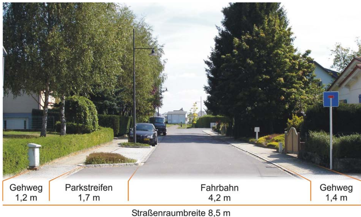
Abb. I.15 Straßenraumbemessung der rue Mathias Saur – westlicher Teilabschnitt
