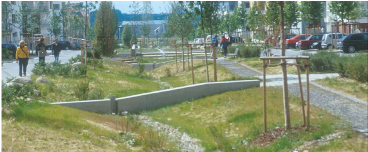
Abb. III.39 Kaskadenförmige Regenrückhaltung - Ansicht und Systemschnitt Fotografie: Ostfildern Scharnhäuser Park
