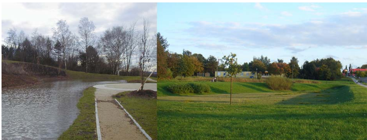
Abb. III.40 Beispiele zentraler Regenwasserversickerung im Park Retentionsteiche und Versickerungsgroßmulden - Wohngebiet Petrisberg Trier
